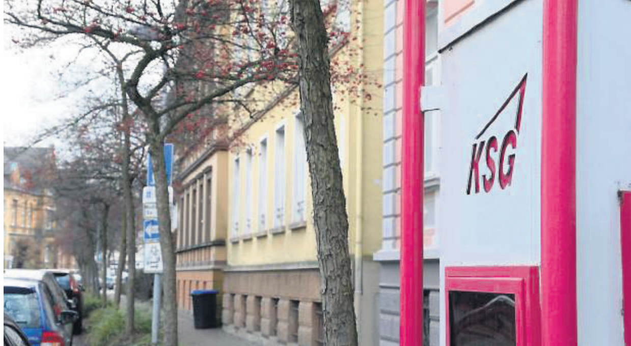
Die Häuser der KSG an der Wilhelmstraße sollen saniert werden. FOTO: DANA
